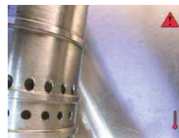
Sistema de Alarma de Temperatura
