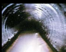
Servicio en Línea de Agua - Inspección Básica
